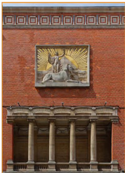
Vues (intérieure et extérieure) du Grand Temple de Lille
